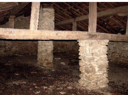
Corral del Paso. Interior
