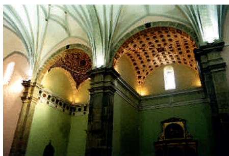
Iglesia parroquial de Monterde. Detalle de algunas de las soluciones de cubierta de las capillas del lado de la Epístola
