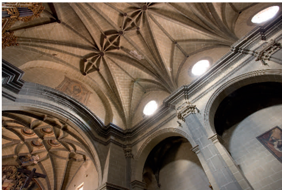
Catedral de Albarracín. Bóvedas de crucería de la nave
