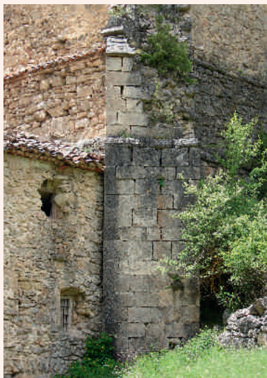
Contrafuerte de sillería
