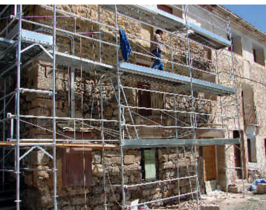
Rehabilitación del antiguo molino de Royuela
