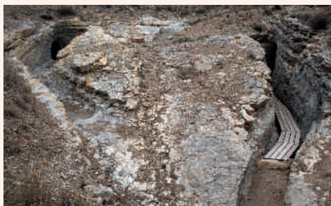
Aliviaderos. Cañada de Monterde (Gea de Albarracín). Tramo V
