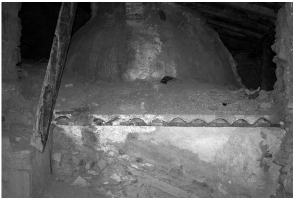
Fig 5. Bóveda, antiguos muros exteriores y línea de tejado sobre la antigua capilla del Pilar.
