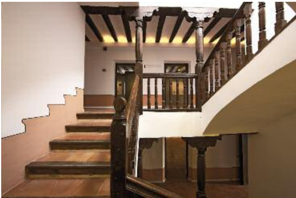
Fig. 2. Detalle de la escalera del Antiguo Hospital de Albarracín.
