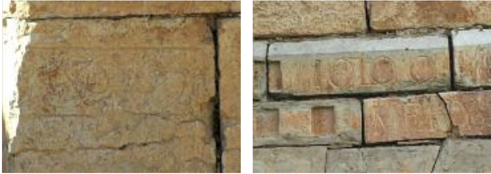
Fechas de la construcción del convento esculpidas en piedras de la construcción.
