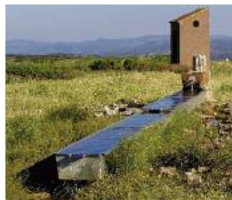
Casetas de la conducción de agua entre Las Tejedas y Santa Eulalia. Delante de ella la fuente (con abrevadero metálico) cuya agua procede de la conducción. Se hallan la fuente y la casetas entre la Masía del Rebollo y la Masía Evaristo (término de Bronchales; julio 2010)
