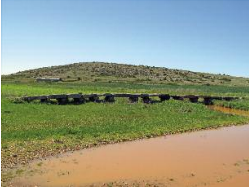
Puente artificial de bloques de arenisca para permitir el acceso al prado de Ródenas cuando está inundado por las lluvias
