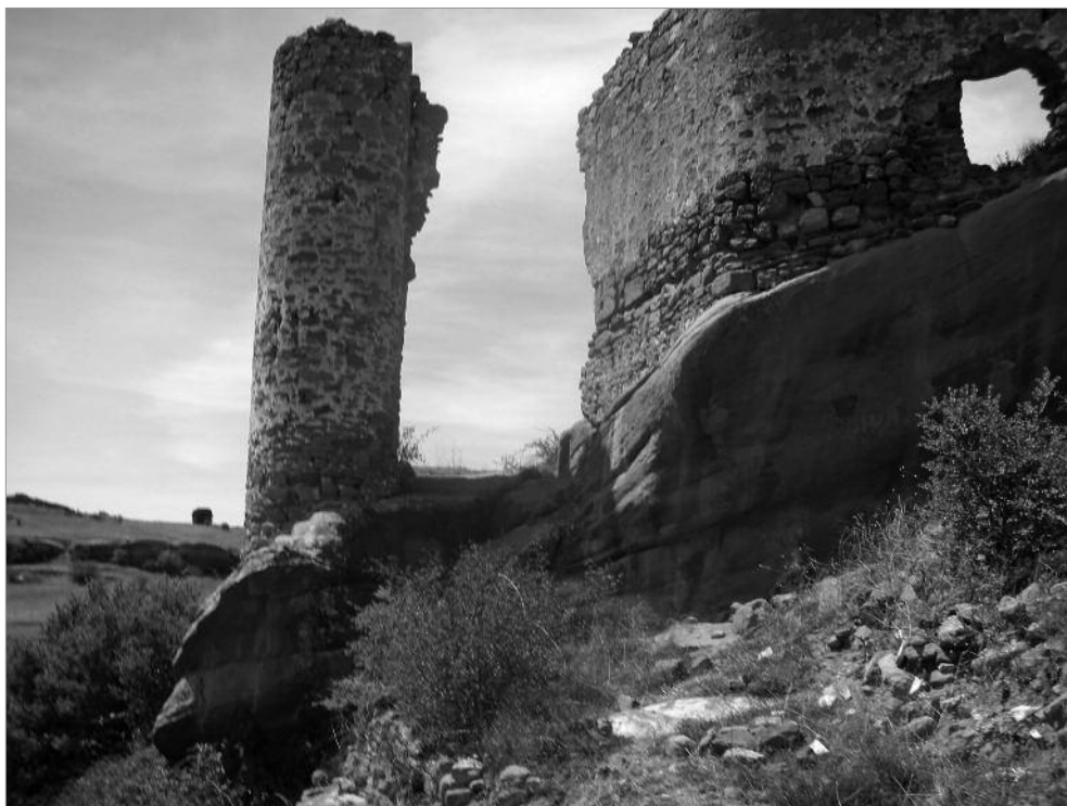
1.- Detalle del torreón y rampa de entrada al castillo, por el Noroeste.
