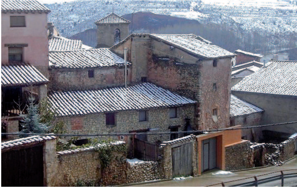
5. En esta foto de la calle Curadero, hecha desde la carretera, en la vivienda del centro y en su segundo piso se observa el ventanico comentado.
