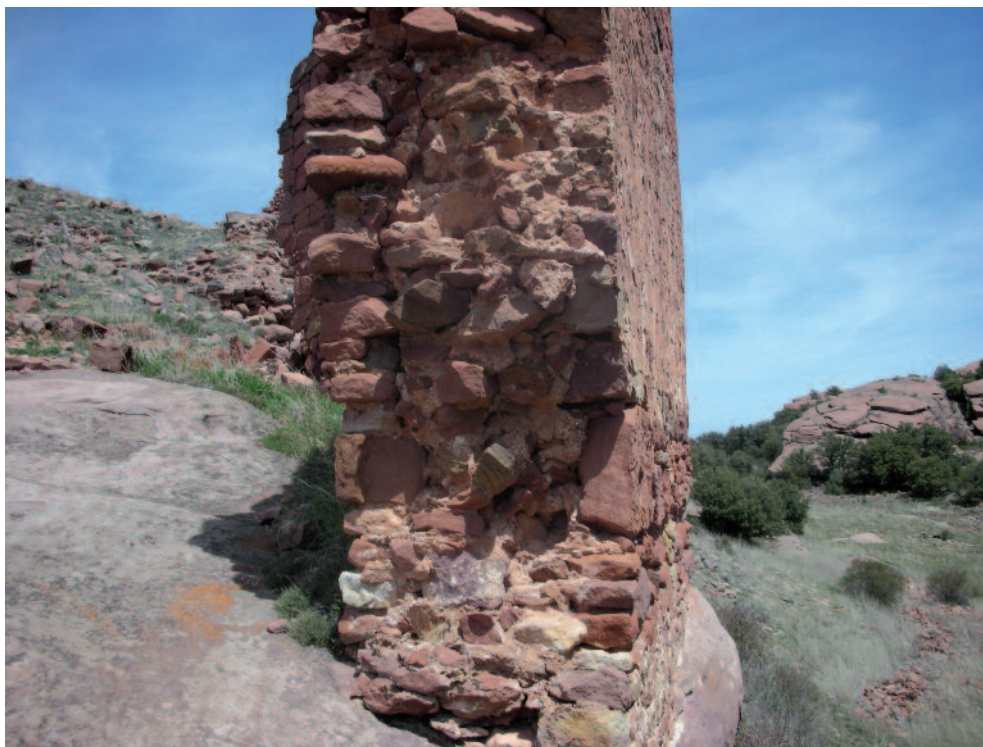
1. Restos del recinto exterior del castillo.
