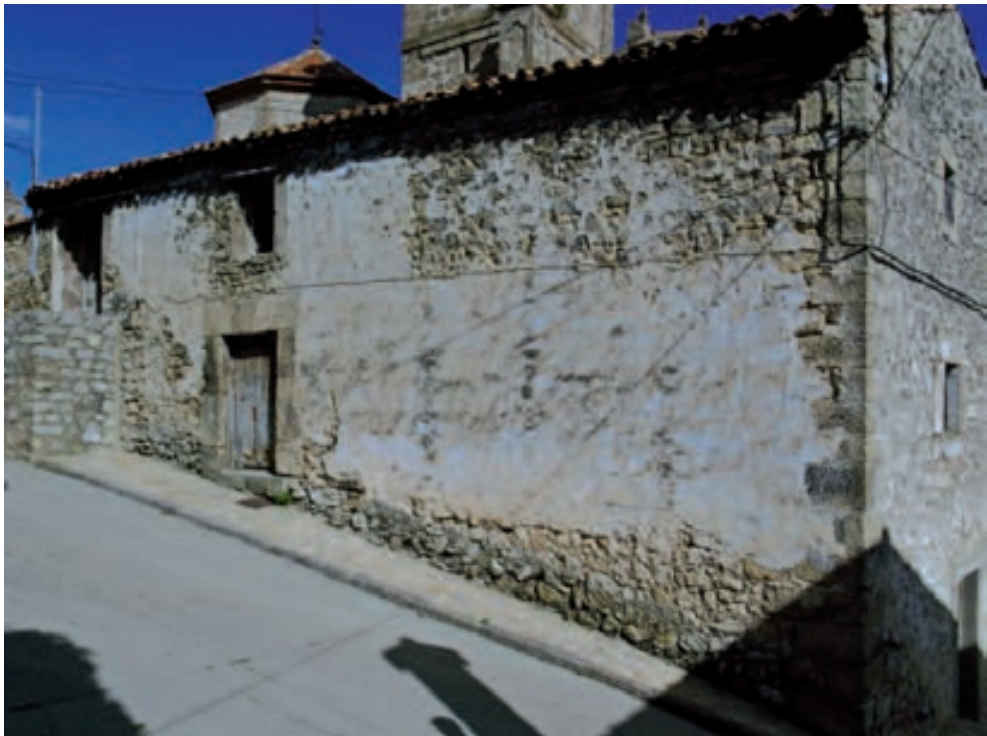
Fachada posterior de la casa de diezmos de Orihuela del Tremedal.
