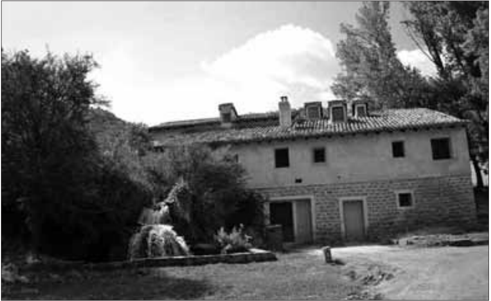
Edificio de la antigua fábrica de lanas.
