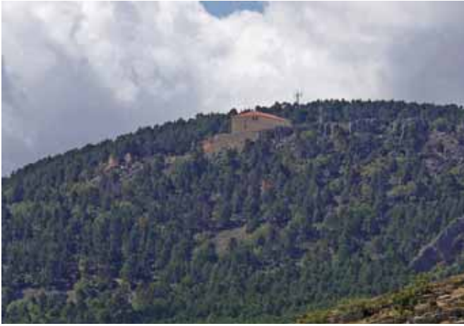
Base fortificada del santuario del Tremedal. A la izquierda de la imagen restos de las dos hospederías.
