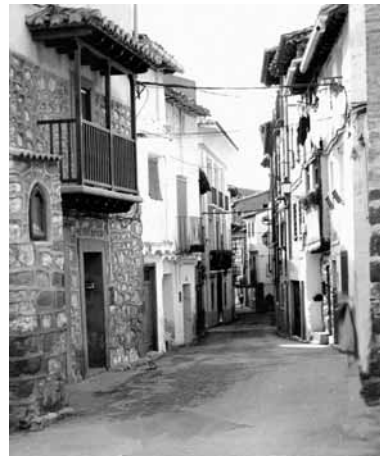
Portal de Teruel, estado actual.
